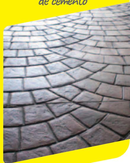
La técnica del estampado o impresión de pisos consiste en, una vez colado el mortero o espolvoreado el hormigón (según si se estampará sobre **weber alisado color** o **weber print**), poner sobre la superficie aún plástica moldes flexibles de diversas texturas (adoquín, laja, baldosas, etc.) presionando y levantando para dejar el diseño del molde impreso sobre la superficie. Los moldes de estampado se fabrican en diversos tamaños y formas. Otorgan textura y diseño.
