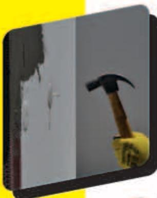
Espiga de fijación de polipropileno con clavo expansionante para la fijación mecánica de placas aislantes en los sistemas **webertherm** (longitudes: 90 y 120 mm.).
