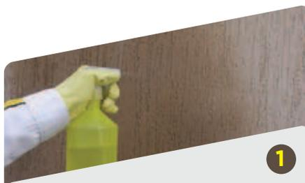
Aplicar 1ra mano a soplete, a presión, pulverizador, rodillo o pincel hasta saturar bien la superficie.
